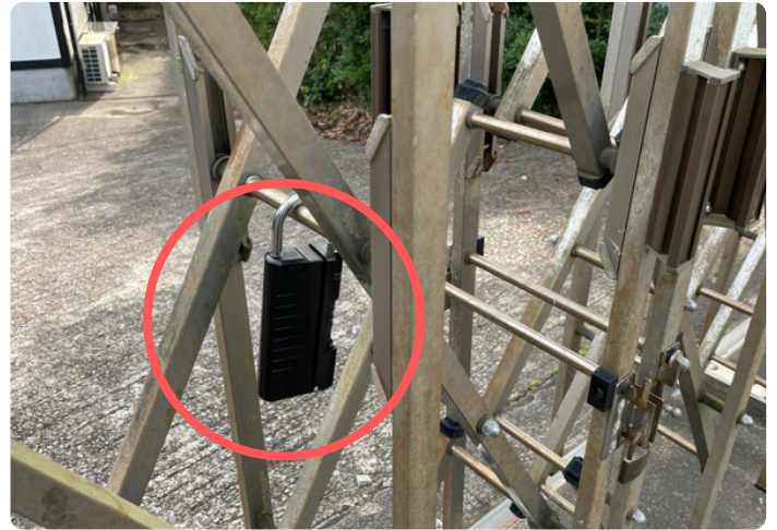
キーBOXは駐車場前のカーテンゲートについています
